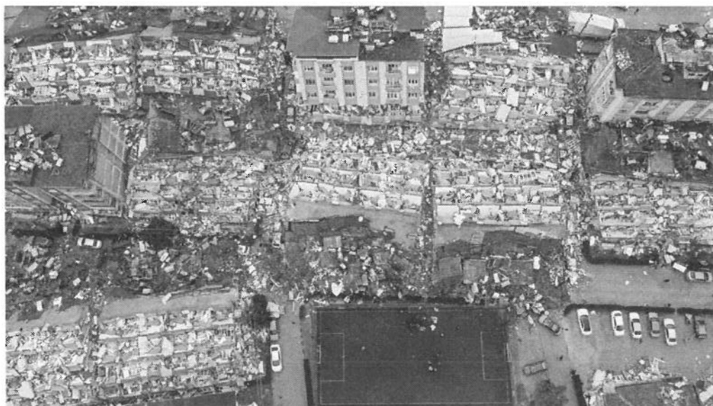
Рис. 3. Последствия землетрясения в Турции в 2023 г.
